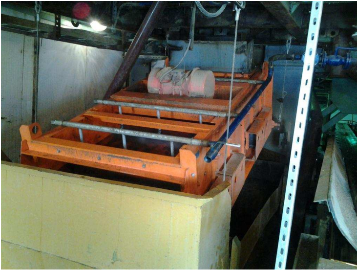
В помещении драги на прииске россыпного алмазного месторождения.
